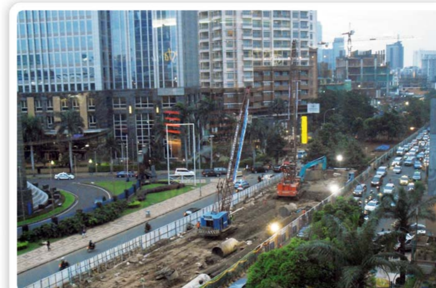
Pelaksanaan pondasi bor pile proyek Jalan Layang (Flyover) Non Tol Kampung Melayu-Tanah Abang, Jakarta.
