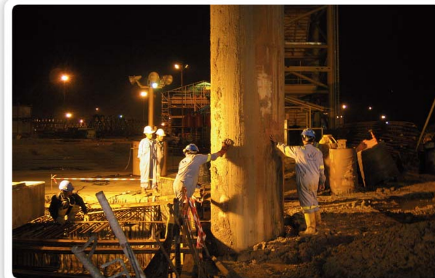
Pelaksanaan pondasi tiang bor proyek SKIDWAY, Batam.
