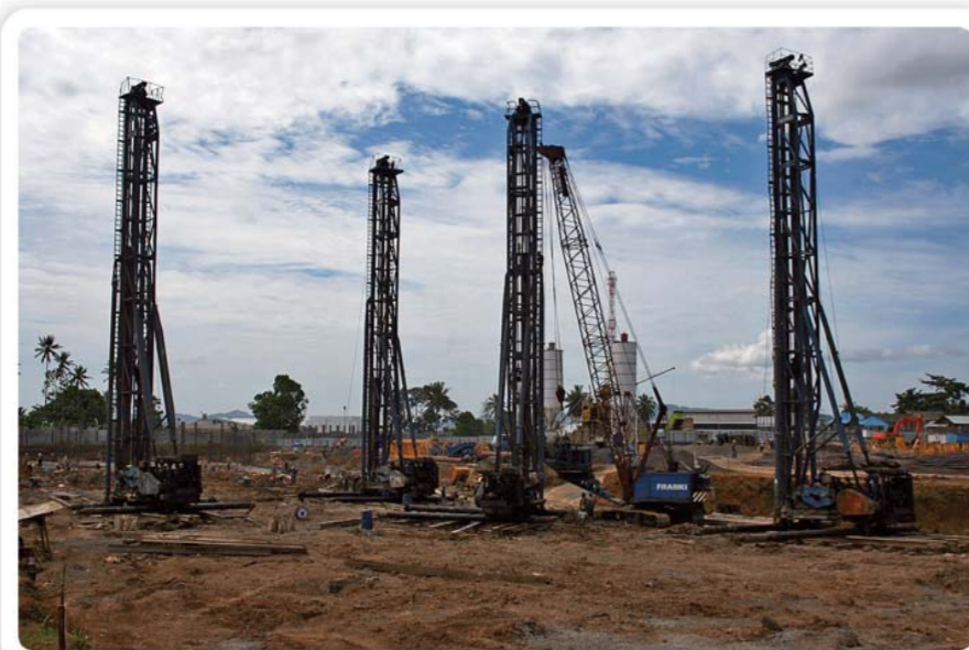
Pekerjaan pondasi di proyek Hotel Sutan Raja, Manado.
