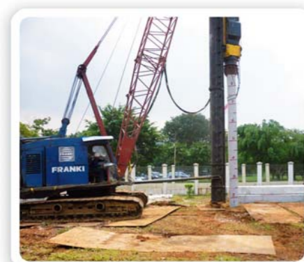
Pekerjaan pemancangan di proyek Gedung Fakultas Kedokteran UKI, Jakarta.
